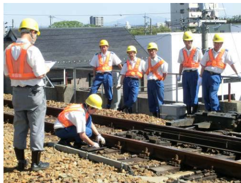
転てつ器の鎖錠訓練・技能確認
