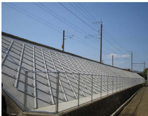
のり面改良工事
