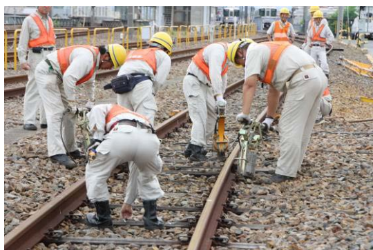
破損した線路の修復訓練
