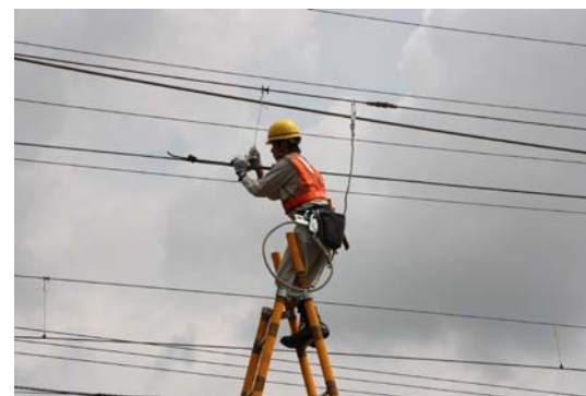
破損した架線の修復訓練
