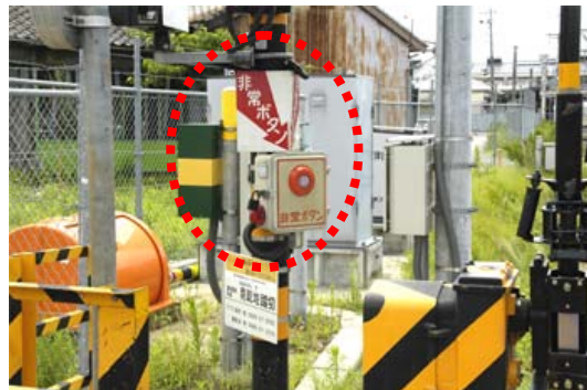
踏切の「非常ボタン」
