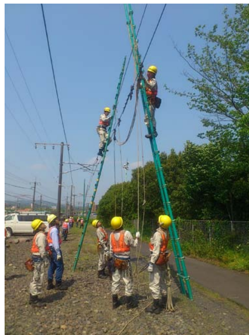
電力係員による電車線復旧合同訓練
