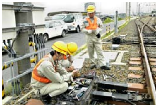
電気転てつ器の修繕
