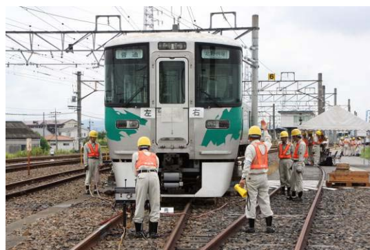
油圧ジャッキ使用による脱線車両の復旧訓練
