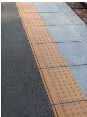
内方線付き点状ブロック
