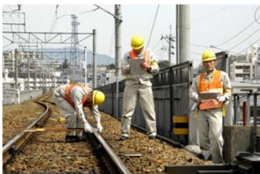
線路の保守点検
