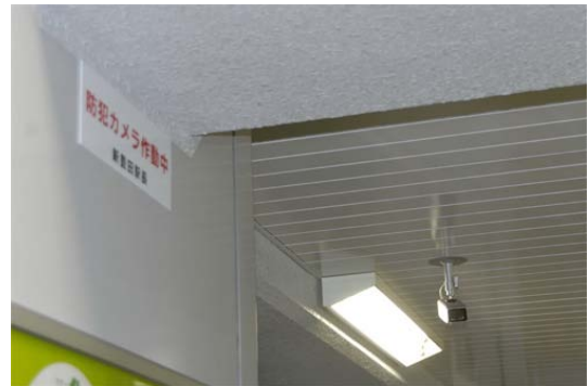
駅構内に設置した防犯カメラ
