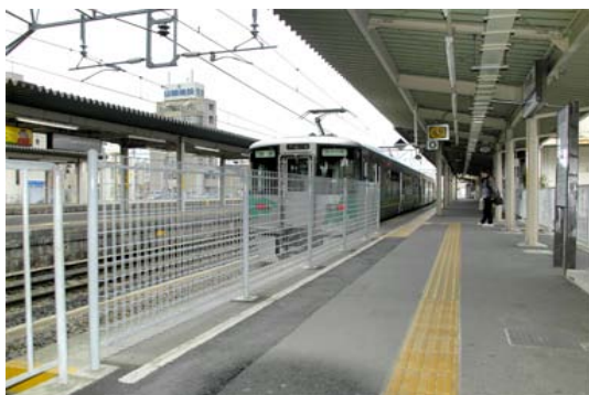
岡崎駅のホーム転落防止柵
