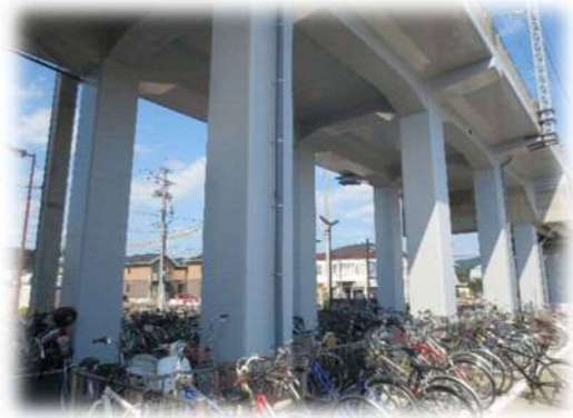
橋脚耐震補強
