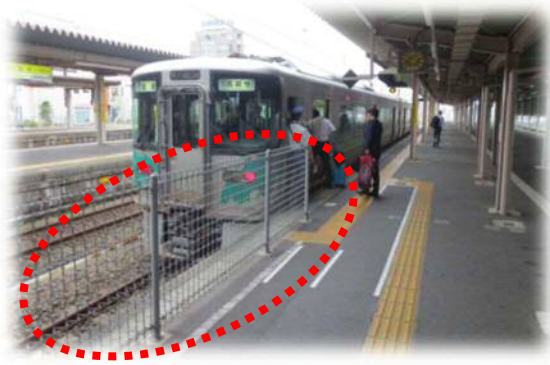
岡崎駅のホーム転落防止柵
