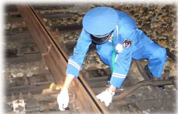
乗務員による分岐器の手動操作
