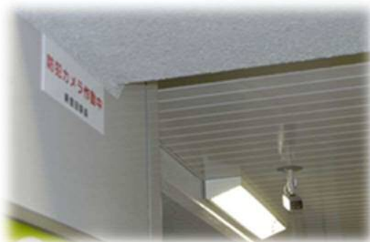
駅構内に設置した防犯カメラ
