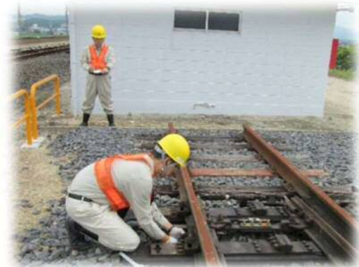
分岐器の手動操作訓練
