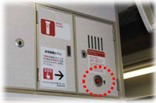
車内に設置してある非常警報ボタン
