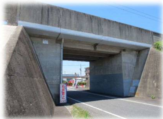
橋りょうのコンクリート剥離修繕
