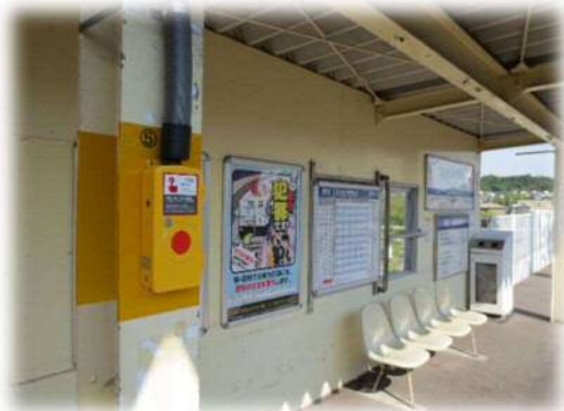
列車非常停止装置新設
