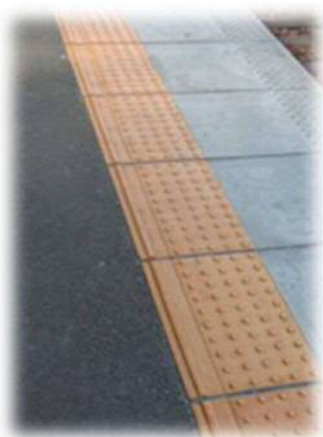
内方線付き点状ブロック
