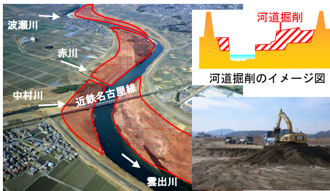
須賀瀬・元町地区河道掘削
