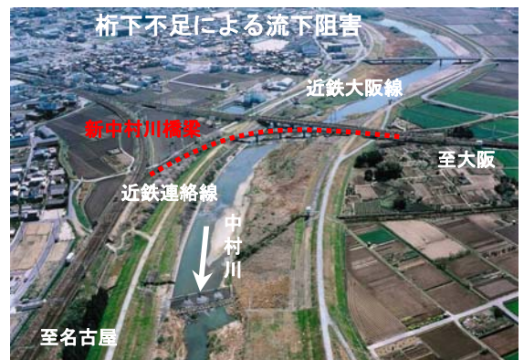
特定構造物改築事業 近鉄新中村川橋梁改築
