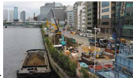
工事残土を舟運を用いて搬出する様子 ▶
