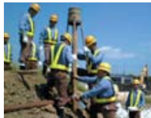
現地研修では、経験豊富な社員が中心となって若手社員に訓練を行っています。保線作業の要領や防災時の対応などの技術継承に努めています。
