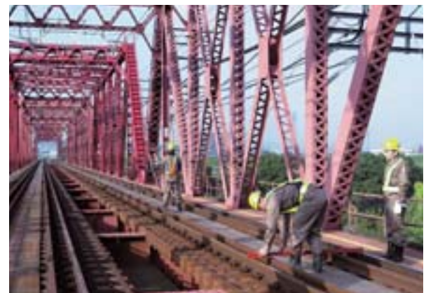
▲ 軌道検測作業
