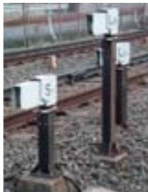
踏切障害物検知装置 ▶
