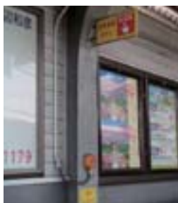
ホーム異常通報装置 ▶
