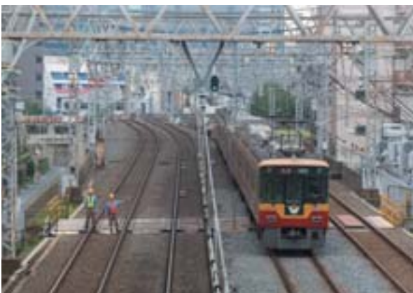
▲ 線路巡視作業
