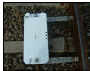
トランスポンダ地上子
