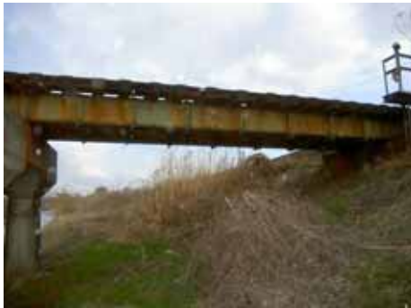
橋梁対策工事（施行前）
