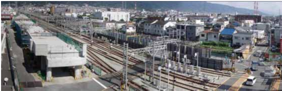
奈良線 八戸ノ里～瓢箪山間連続立体交差化工事
