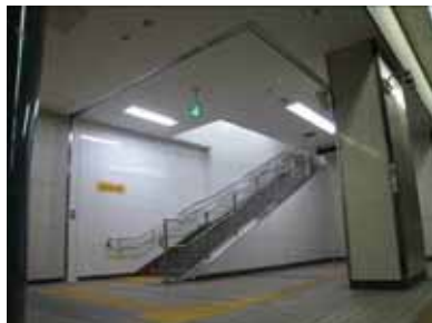
避難階段通常の状態
