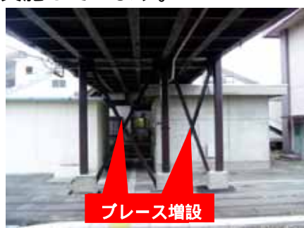
駅舎等の耐震補強工事（完了後）
