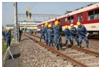
復旧作業を行う施設係員
