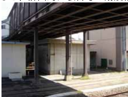
駅舎等の耐震補強工事（施行前）
