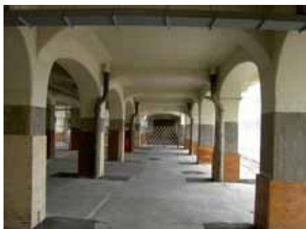
高架橋の耐震補強工事（施行前）
