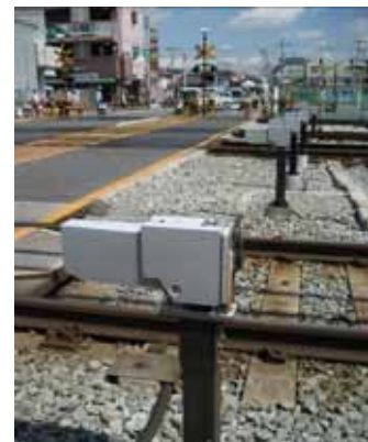
踏切障害物検知装置
