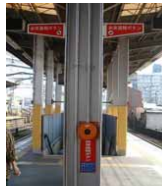
非常通報ボタン
