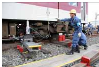
脱線した車両を元に戻す
