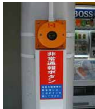
非常通報ボタン
