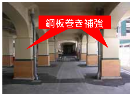
高架橋の耐震補強工事（完了後）
