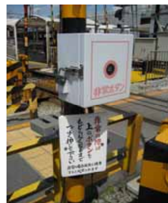
押ボタン式踏切支障報知装置 非常押ボタン
