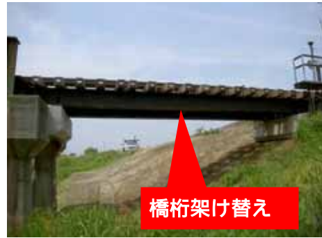
橋梁対策工事（完了後）
