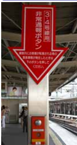
非常通報ボタン
