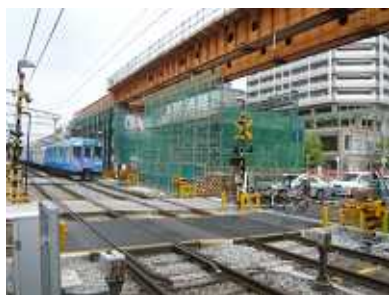
奈良線 八戸ノ里～瓢箪山間
