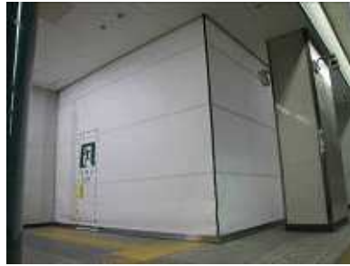
耐火スクリーン降下状態
