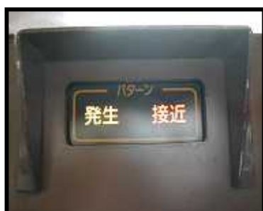
運転台ATS表示
