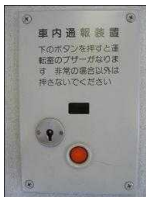
車内通報装置
