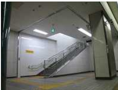
避難階段通常の状態
