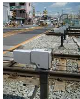
踏切障害物検知装置
