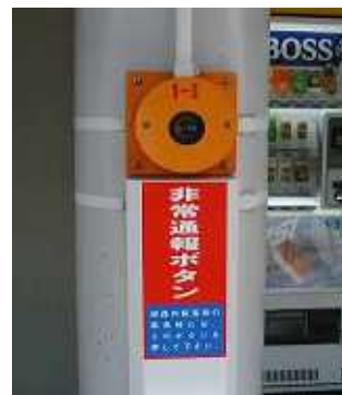
非常通報ボタン
