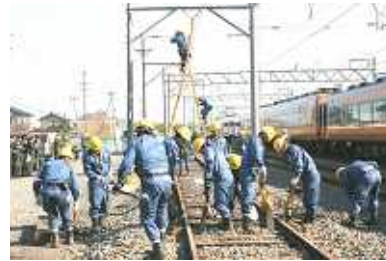
復旧作業を行う施設係員
