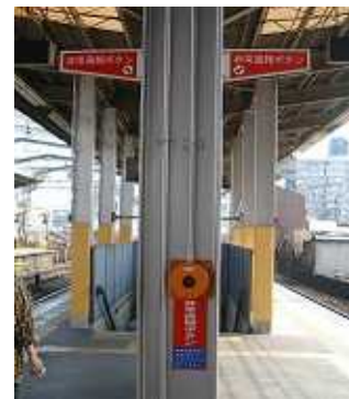
非常通報ボタン
