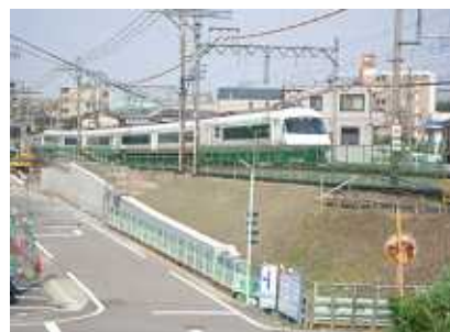
名古屋線伏屋駅付近
