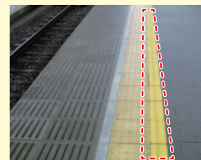
ホーム点字ブロック内方線
