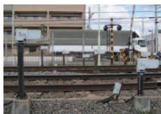
踏切障害物検知装置
