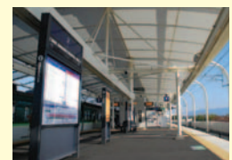
膜構造を採用したホーム屋根
