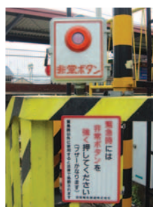
踏切支障報知装置
