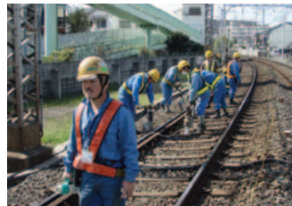
道床突固め作業
