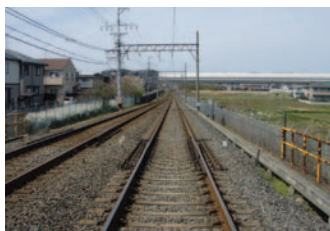
ロングレール
