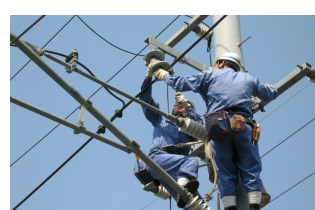
電車線の点検
