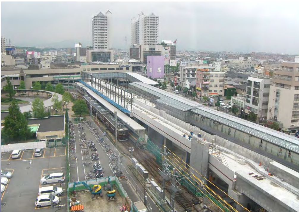
今津南線 高架化工事
