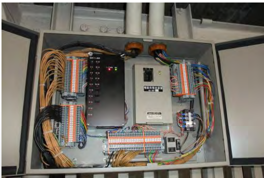
転落支障報知装置の断線検知回路の開発
