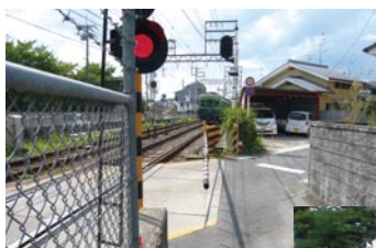
踏切より手前に降下していた遮断桿
