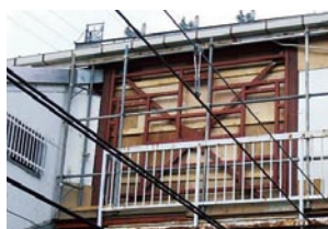
橋上駅舎への耐震補強部材設置状況
