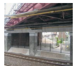
JR奈良線東福寺跨線線路橋
