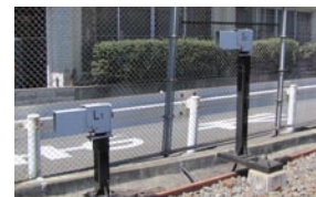
踏切障害物検知装置
