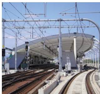
高架化された上り線
