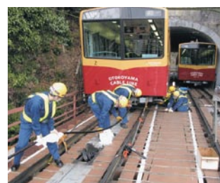
鋼索の点検・整備
