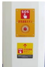
非常通報ボタン
