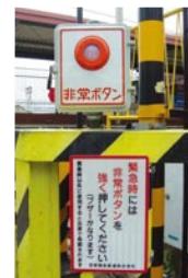
踏切支障報知装置
