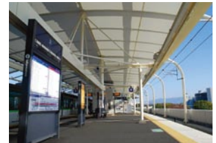
膜構造を採用したホーム屋根
