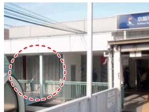
橋上駅舎への耐震補強部材の設置状況
