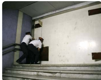
防潮扉閉鎖訓練（水防訓練）
