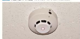
8 煙感知器(自動火災報知設備)
