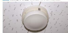
9 熱感知器(自動火災報知設備)
