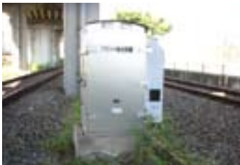
フラット検出装置
