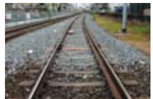
道床交換(完了)
