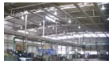
寝屋川車両工場のLED照明
