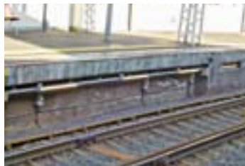
LED足下灯設備
