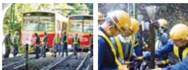
鋼索線の点検・整備
