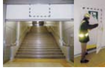
防火防煙シャッター
