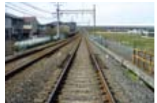
ロングレール
