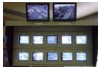
併用軌道監視装置
