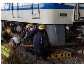
脱線車両の復旧
