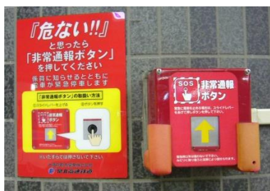
非常通報ボタン
