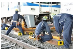
脱線車両の復旧
