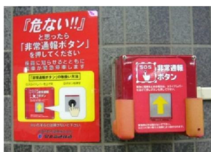
非常通報ボタン
