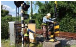
踏切保安装置の復旧訓練
