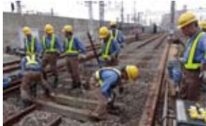
軌道の保守作業実務訓練
