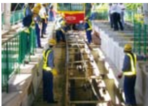
鋼索線の点検・整備
