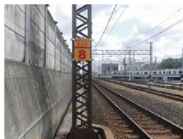
セクションクリア表示板
