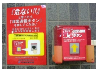
非常通報ボタン
