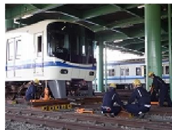
脱線車両の復旧
