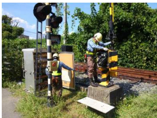
踏切保安装置の復旧訓練
