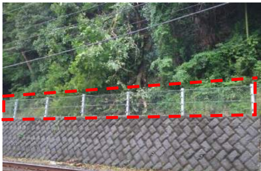
土砂崩壊検知装置
