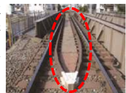
橋上ガードレール
