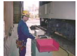
輪重測定装置による管理
