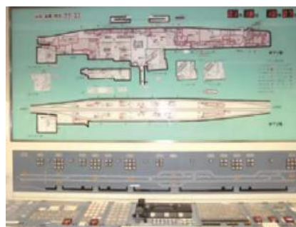
地下線防災監視盤
