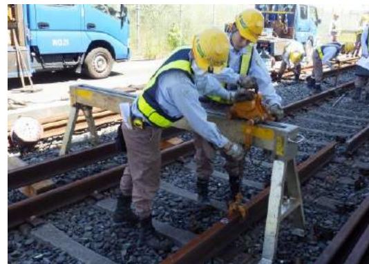
軌道の保守作業実務訓練
