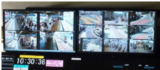
併用軌道監視装置
