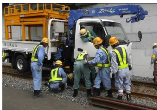
架線車の脱線復旧訓練
