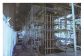
高架橋耐震補強
