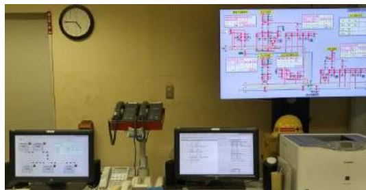
電力管理システム
