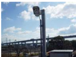
河川監視カメラ
