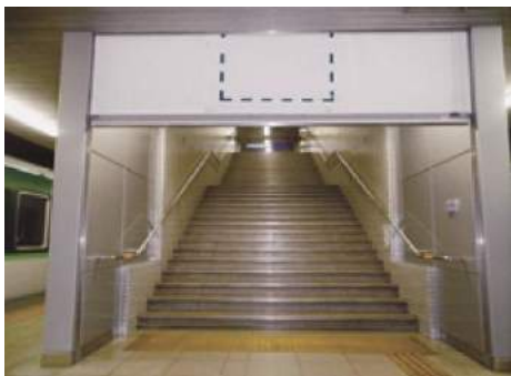
防火防煙シャッター
