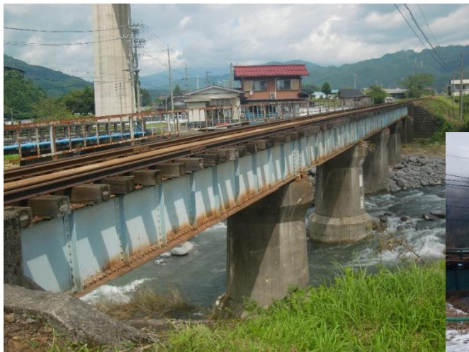
橋梁塗装・橋脚補修 牛道川橋梁 (施工前)
