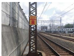
セクションクリア表示板
