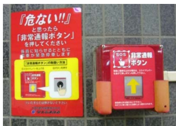
非常通報ボタン
