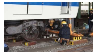
脱線車両の復旧
