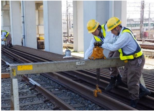
軌道の保守作業実務研修
