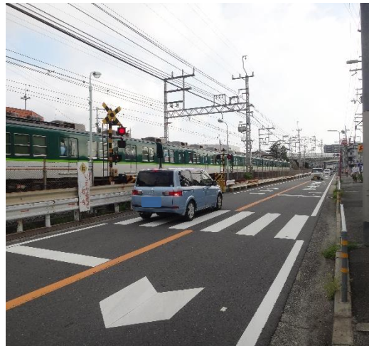
現況 (光善寺駅～枚方公園駅間)
