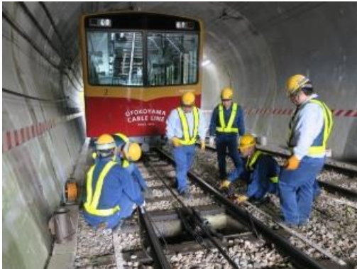
鋼索線の点検・整備
