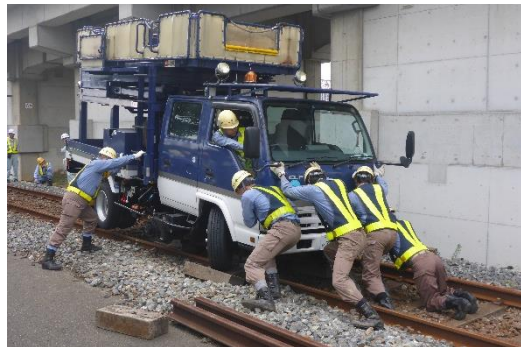
架線車の脱線復旧訓練
