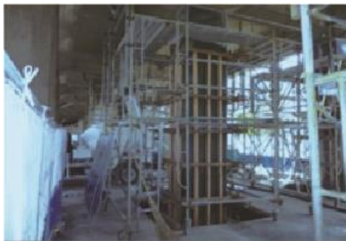
高架橋耐震補強
