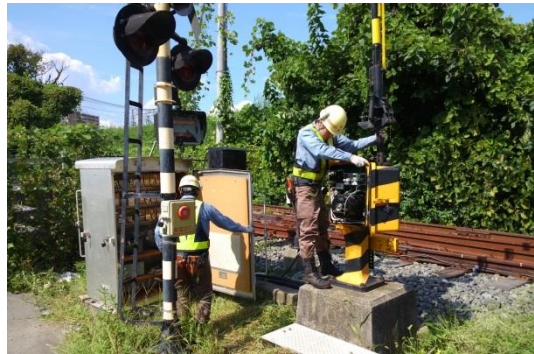
踏切保安装置の復旧訓練
