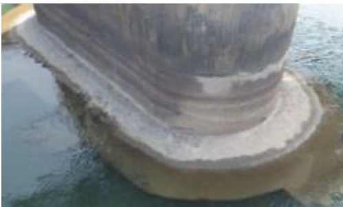
補強工事前の橋脚
