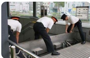
止水板立上げ訓練(水防訓練)
