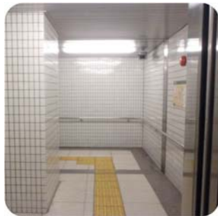
(対策前) 駅構内の死角がある通路
