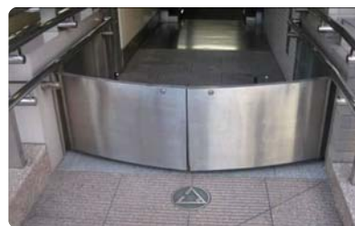
機械式止水板
