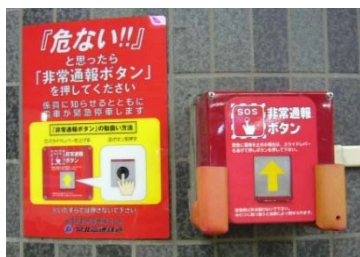
非常通報ボタン
