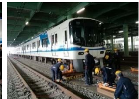
脱線車両の復旧
