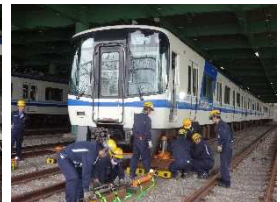
脱線車両の復旧
