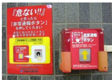
非常通報ボタン
