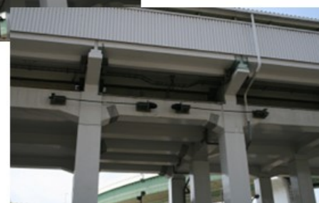
落橋防止工事
