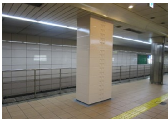
耐震補強工事
