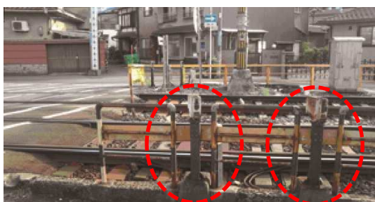
自動車侵入検知装置
