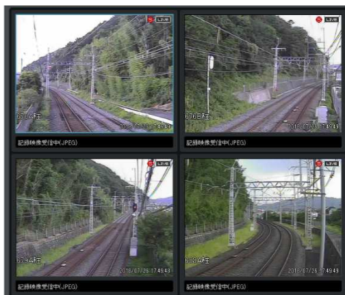
急傾斜法面監視カメラの映像
