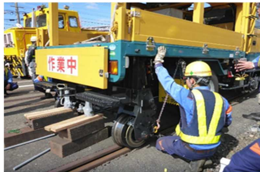
架線車の脱線復旧訓練
