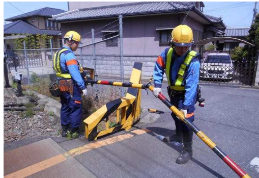
踏切保安装置の復旧訓練
