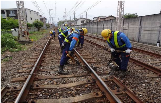
軌道の保守作業実務研修
