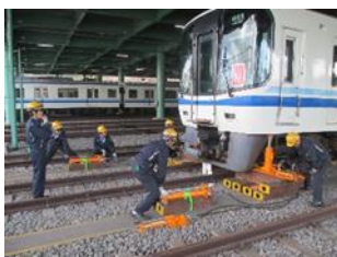
脱線車両の復旧
