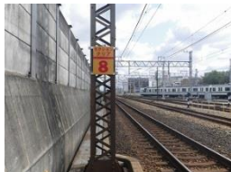
セクションクリア表示板
