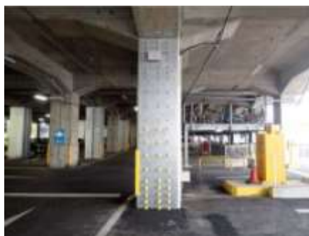
[一面耐震補強工法(別府駅)]
