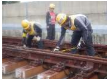
[工務関係技能競技会(分岐器)]
