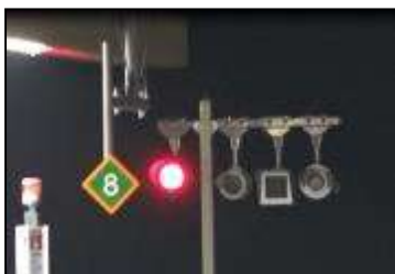
[ホーム下への転落を検知した状態] (赤色灯点滅(写真上))
