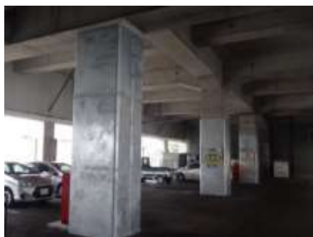
[鋼板巻立補強工法(行橋駅)]
