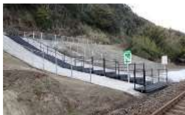
[津波避難階段(2019年度新設)]
