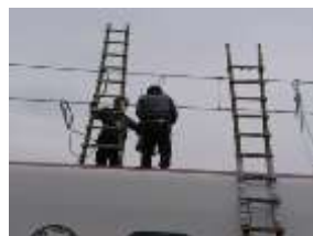
[車両上での電車線復旧訓練]
