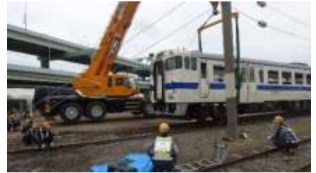
[クレーンによる列車の載線(本社直轄)]
