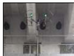
[ドローンによる構造物点検訓練]
