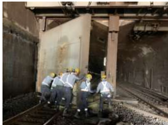
[トンネル内防水扉の閉扉]
