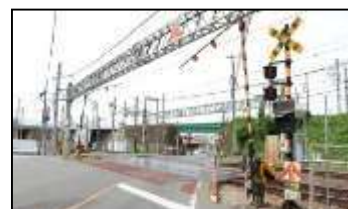
[踏切の安全対策]
