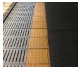
[内方線付き点状ブロック]
