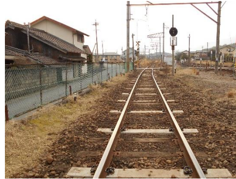
(コンクリートまくら木への更新後)
