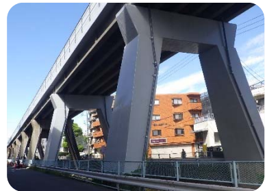
構造物の耐震補強
