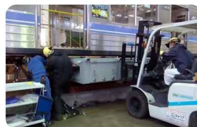
主要電気機器更新
