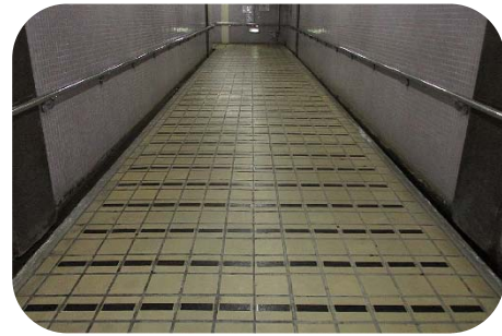
(対策後) 滑り止めを設置
