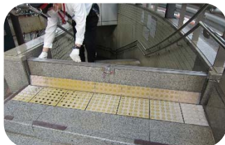
止水板立上げ訓練 (水防訓練)
