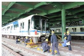
脱線車両の復旧
