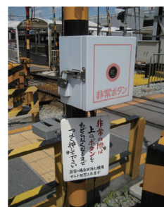
押ボタン式踏切支障報知装置非常ボタン
