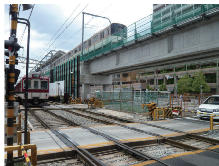
奈良線 八戸ノ里～瓢箪山間
