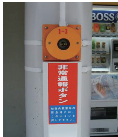
非常通報ボタン
