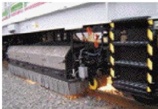
レール削正の状況
