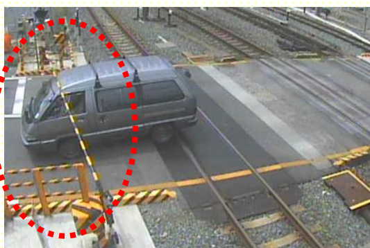
危険！無理な踏切横断による遮断桿折損の瞬間
