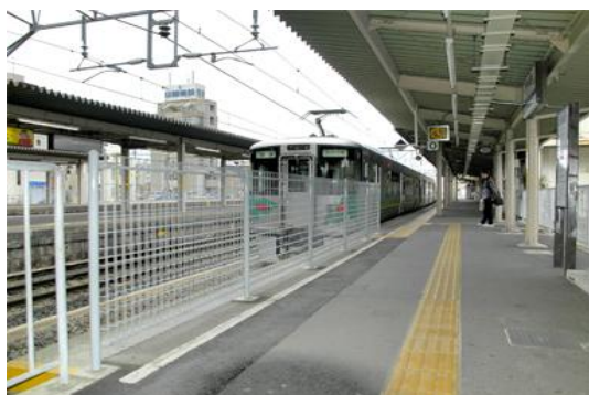
岡崎駅のホーム転落防止柵
