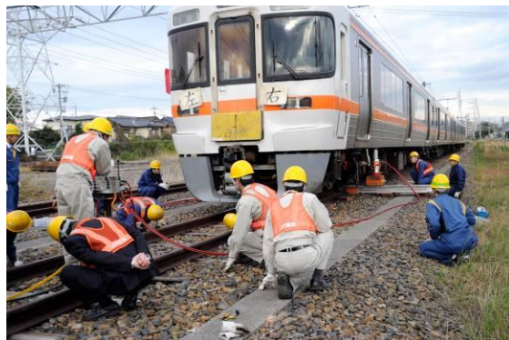
車両係員による脱線復旧合同訓練
