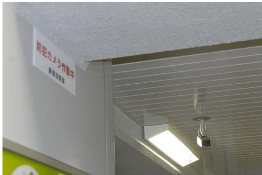
駅構内に設置した防犯カメラ
