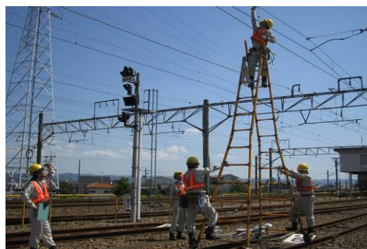
破損した架線の修復訓練
