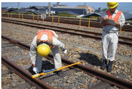
線路の保守点検
