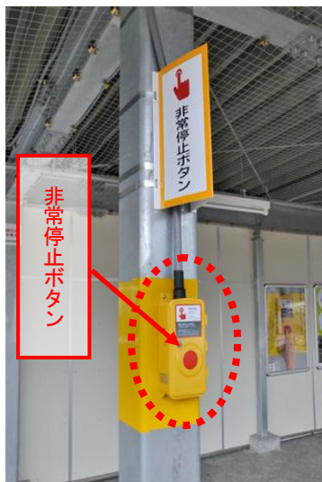
ホーム屋根の柱に設置した列車非常停止装置
