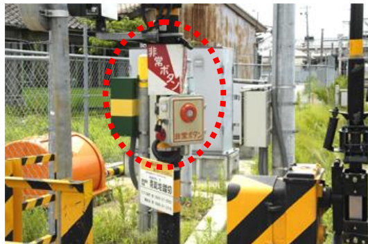
踏切の「非常ボタン」
