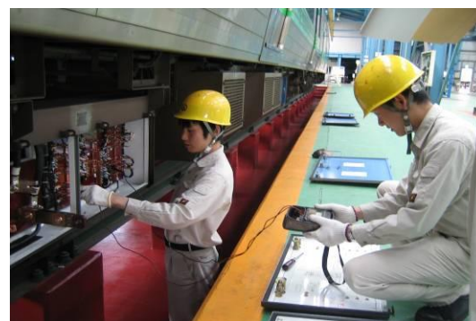
車両の保守点検
