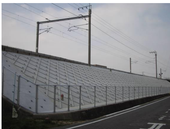
のり面改良工事
