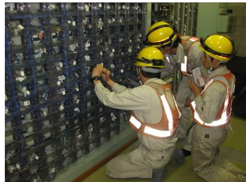
電気係員による軌道回路故障復旧訓練
