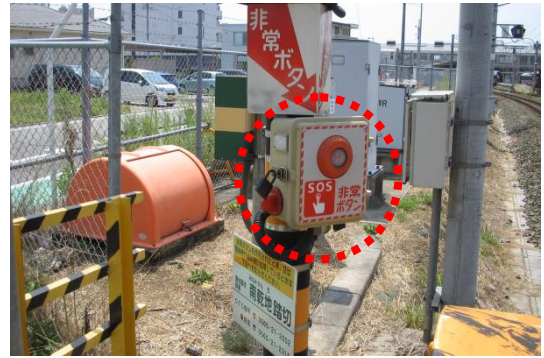
踏切の「非常ボタン」
