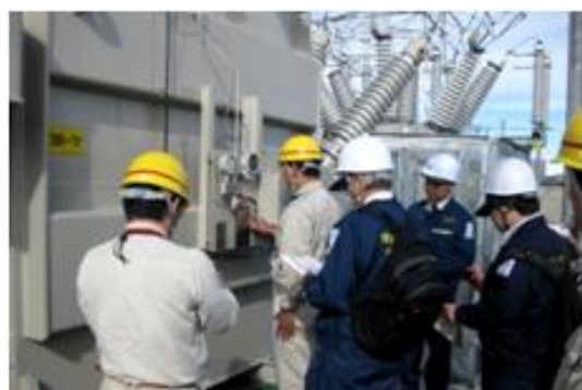
変電所機器老朽取替
