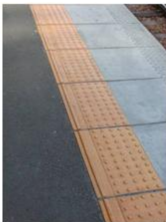
内方線付き点状ブロック
