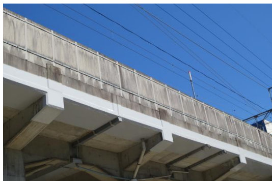
橋りょうのコンクリート剥離修繕
