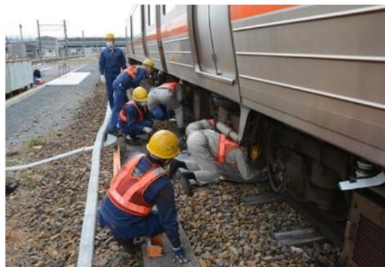
車両係員による応急復旧合同訓練
