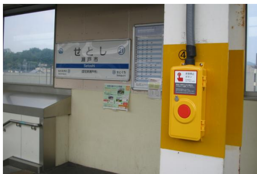
列車非常停止装置新設
