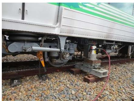
油圧ジャッキによる脱線復旧作業
