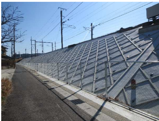
のり面改良（北野榊塚駅～三河上郷駅間）
