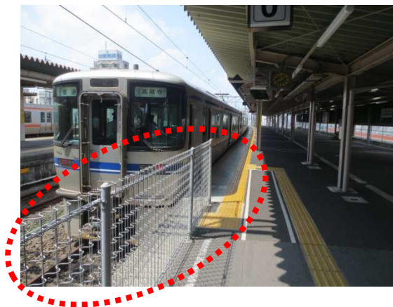
岡崎駅のホーム転落防止柵
