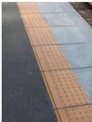
内方線付き点状ブロック
