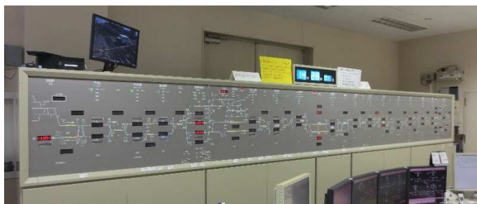
規制値に達すると運行表示盤に警報を表示
