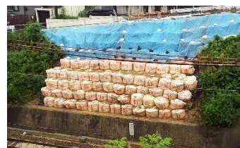
仮復旧の状況
