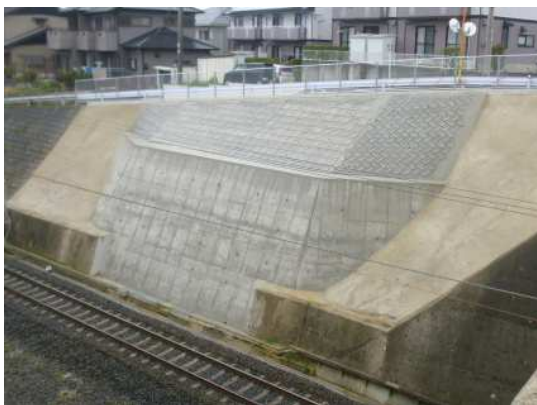
のり面崩落箇所の本復旧
