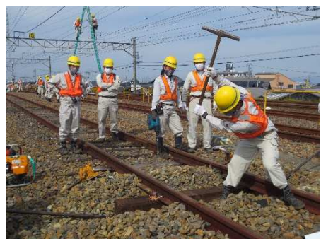
線路の修復作業
