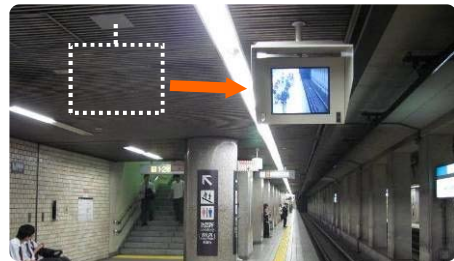
ITV モニタの設置位置の改善
