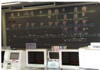
電力管理システムの監視盤
