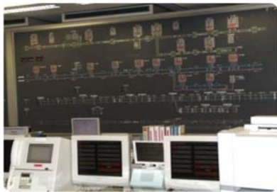
電力管理システムの監視盤
