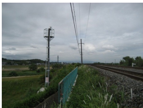
風速計の新設
