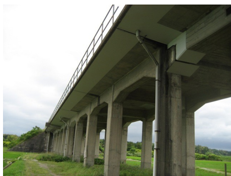
高架橋剥離修繕
