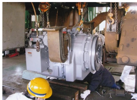
液体変速機取替工事
