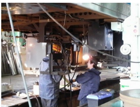
ATS-PT 型車上装置取付工事
