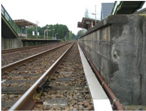
通信ケーブル取替工事
