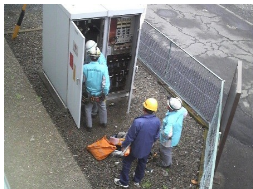
電気設備の点検
