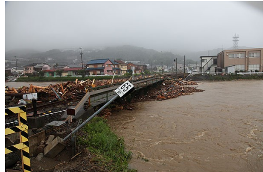
JR 東海紀勢線井戸川橋梁（平成 23 年 9 月 4 日撮影）
