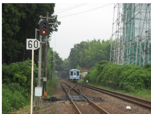
信号機のLED化工事
