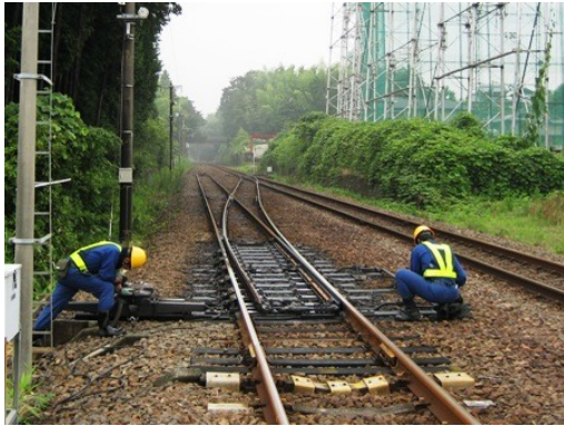
分岐器の点検
