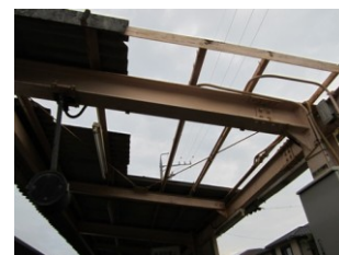
台風4号被害(河芸駅)
