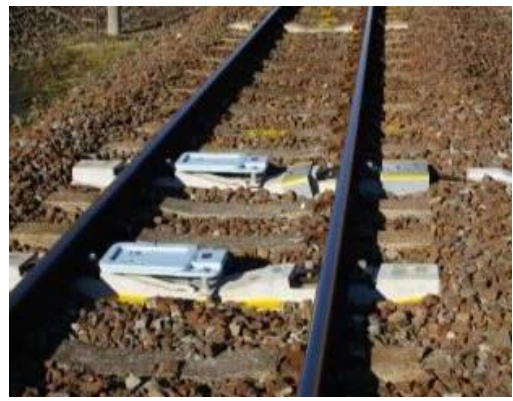
自動列車停止装置（ATS）新設
