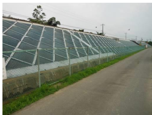
盛土のり面改良工事
