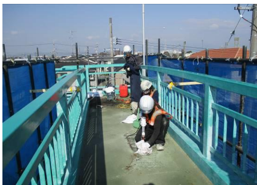
玉垣駅こ線橋改良
