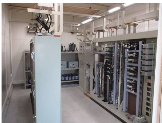
中瀬古駅継電連動装置更新
