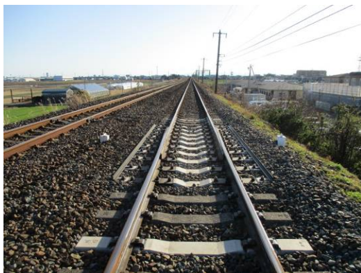
伸縮継目レール更换
