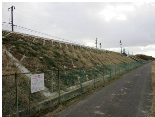
盛土のり面改良
