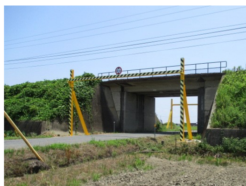
橋桁防護工改良
