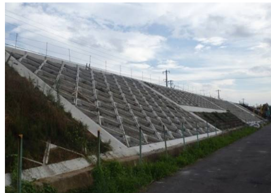
盛土のり面改良
