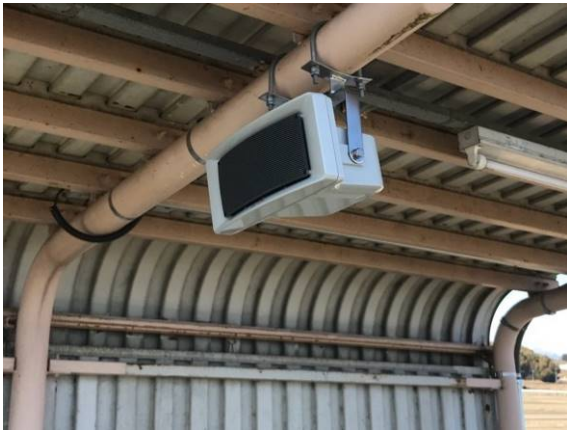
列車接近放送装置新設
