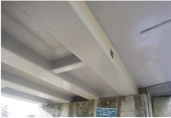
橋りょう等表面保護工施工
